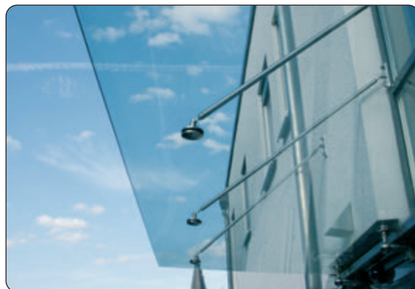
Verbaut an einem Mehrfamilienhaus in Gummersbach
