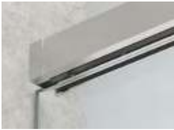
Laufschiene auf das Seitenteil geklemmt
